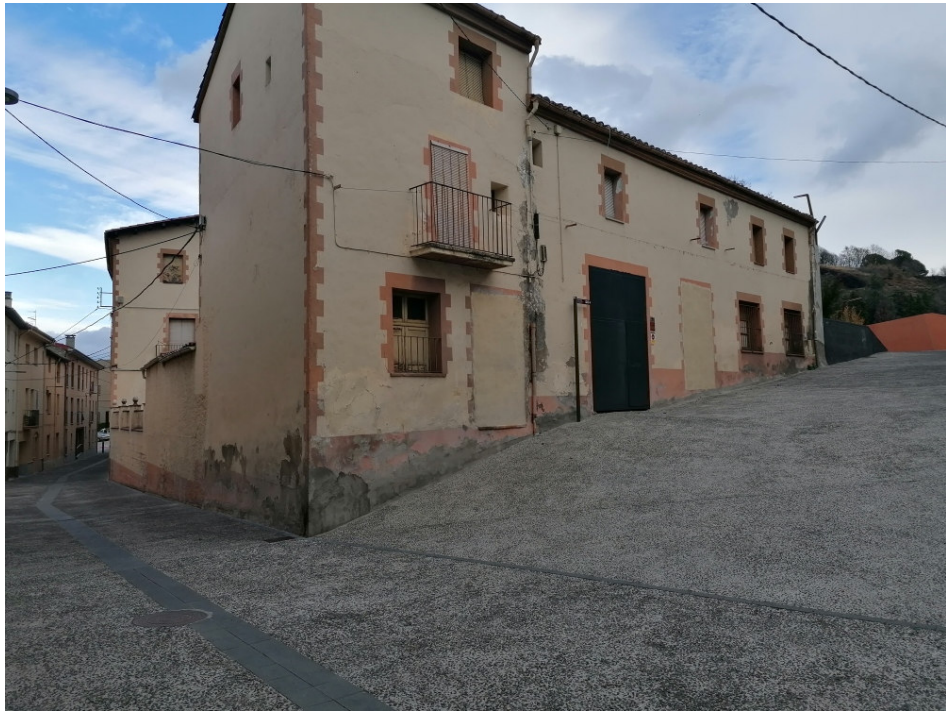
Vista general i detalls obertures de la façana carrer del Roser, 20 (davant Plaça de Braus)
