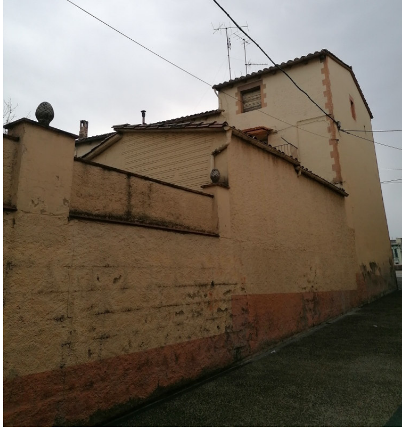
Vista façana lateral del carrer del Roser, 20.
