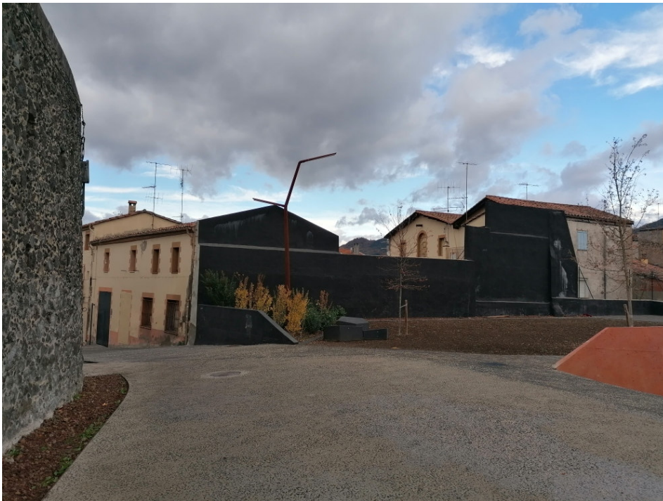
Vista façana mitgera des de espai Plaça de Braus i exterior de l'Espai Cràter
