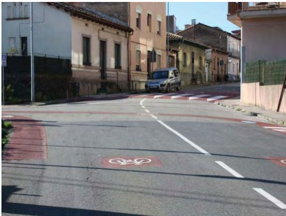
Imatge 13. Connexió ciclista entre carrer Pou de Glaç i carretera de Riudaura. Senyalització molt satisfactòria.
