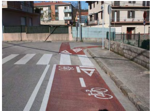
Imatge 14. Carretera de Riudaura. És palès l'esforç en la promoció d'aquest mitjà creant condicions de seguretat per als ciclistes.
