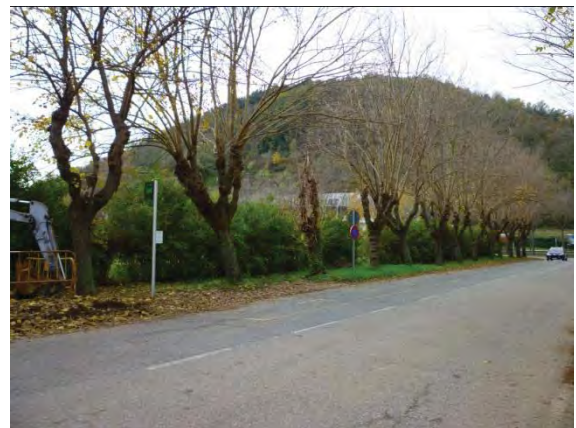
Imatge 28. Parada de bus (P-82) amb pal identificador però sense espai d'espera ni accessibilitat, donat l'entorn en el que es situa
