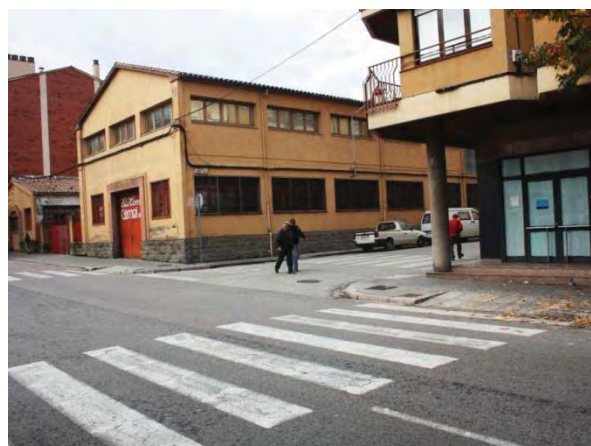
Imatge 10. Carrer Miquel Març amb av. Girona. Per assegurar l'accessibilitat cal eliminar barreres (substituir vorada per guals) i respectar l'itinerari natural del vianant. En cas contrari, es genera risc.
