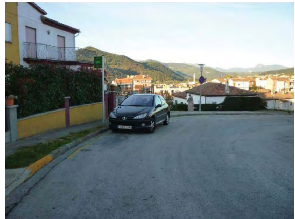
Imatge 26. Parada de bus (P-41) amb vehicle ocupant l'espai senyalitzat i en un tram en corba de radi reduït, que dificulta l'accessibilitat vorera-vehicle
