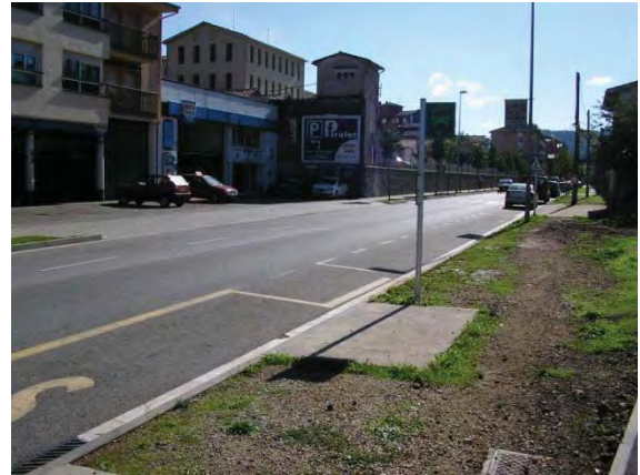
Imatge 24. Parada de bus (P-30) amb pal identificador però no accessible per estar en un entorn de vorera de terra
